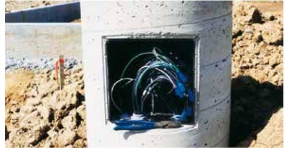
Pour une plus grande souplesse, les couvercles convexes des boîtes J-Box ont des emplacements pour installer des prises et des couvercles étanches aux intempéries. Quant à la maintenance, elle s'en trouve facilitée. Les luminaires peuvent être protégés à partir de la base du poteau et, si nécessaire, les poteaux peuvent même être enlevés et remplacés au milieu du circuit sans que l'éclairage complet n'en soit affecté.
