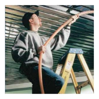
Plenum-Gard est une marque de conduits flexibles ondulés non métalliques pour usage dans les plénums, comme conduit de montée et pour usage général.
