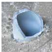
Conduit brisé sur site
