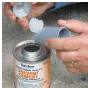
Appliquez une couche uniforme de ciment
