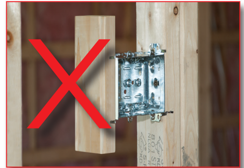
Cette installation N'EST PAS CONFORME à l'article 12-3010 (3) du CCE.
