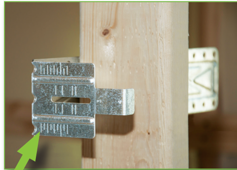
À l'usage des guides estampés dans le support, la profondeur de la boîte peut être réglée pour convenir à l'application.
